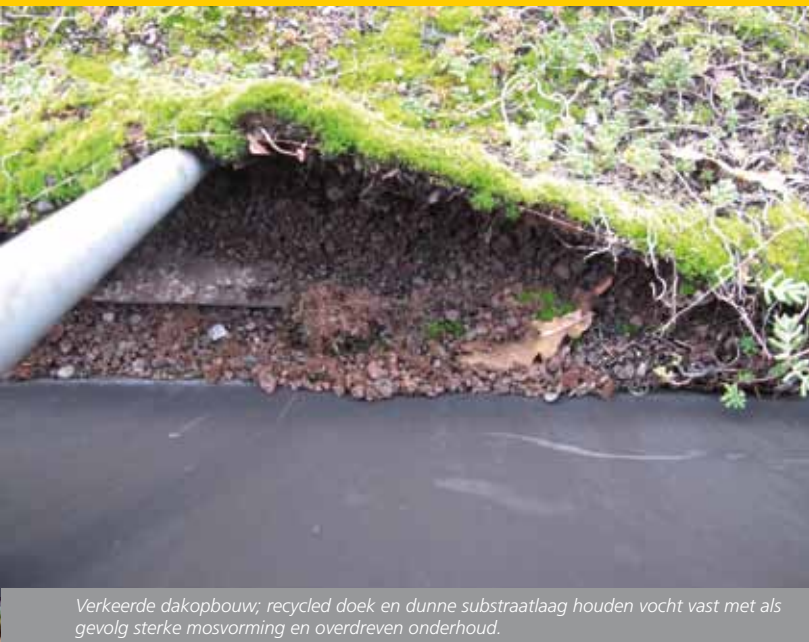
Geen onderhoud geeft verarming van de sedumgroei; door de verkeerde laagopbouw vindt tegelijkertijd verrijking van mossen plaats.
