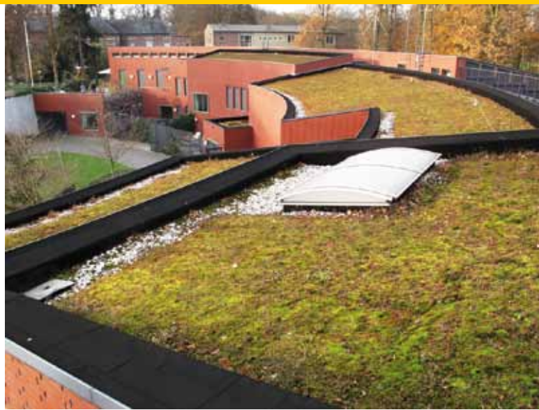
Geen onderhoud geeft verarming van de sedumgroei; door de verkeerde laagopbouw vindt tegelijkertijd verrijking van mossen plaats.
